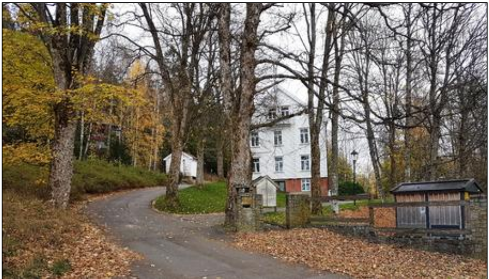
Figur 19: Tidligere Høgli sykehjem, sett fra Høgliveien.
